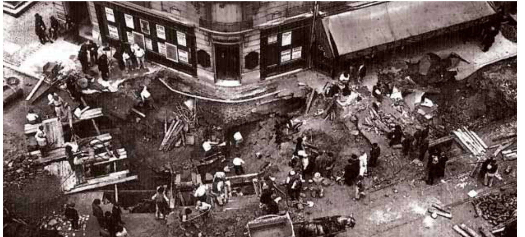
Travaux de terrassement dans Paris vers 1900. Carte postale (Collection Luciano Pagliarini).
